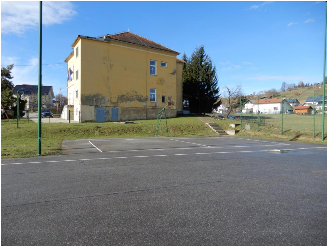
Območje gradnje pogled od vzhoda (Foto 14. 03. 2018)
