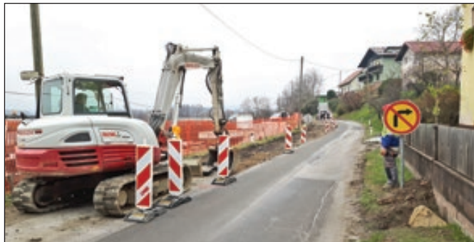
Rekonstrukcija kanalizacijskega omrežja
