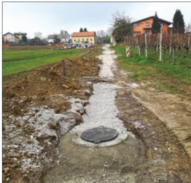
Sanacija plazov na državni cesti
