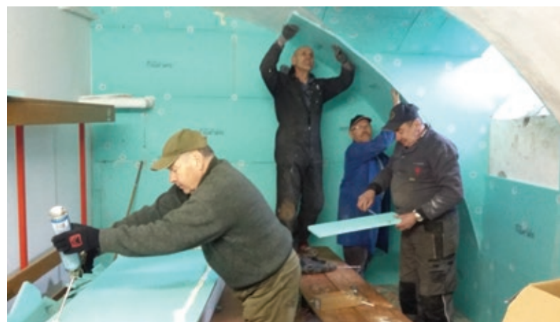
Pričvrščevanje stiropora na stene in strop
