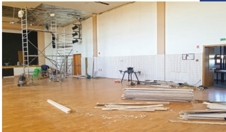
Izvedba zamenjave stropnih in stenskih oblog Foto: Natalija Jakopec
