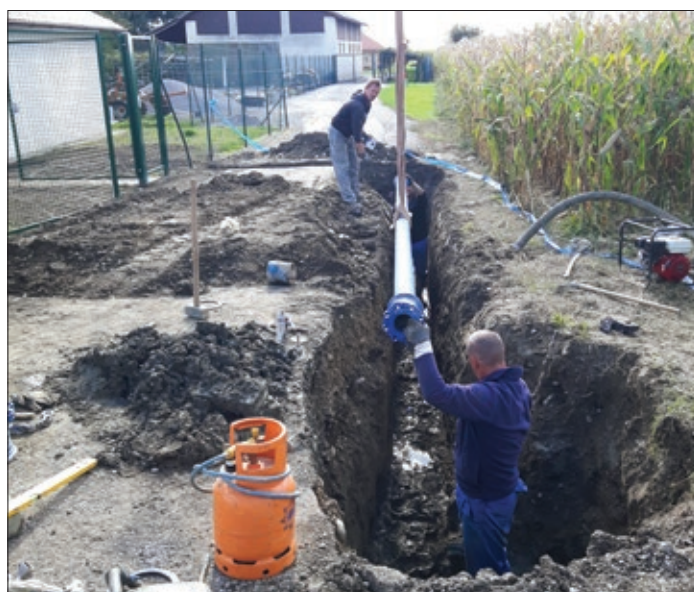
Izvedba montažnih del podjetja Mariborski vodovod, j.p., d.d. Maribor ob vzpostavitvi tlačno merne cone PP Johe.
