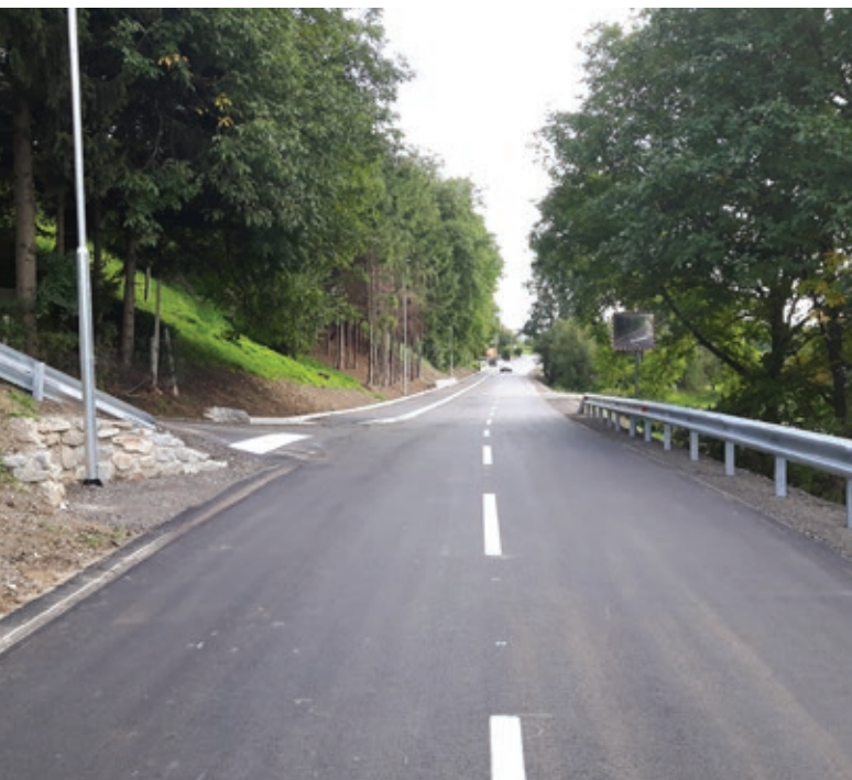
Rekonstrukcija ceste v Zapoutkah
